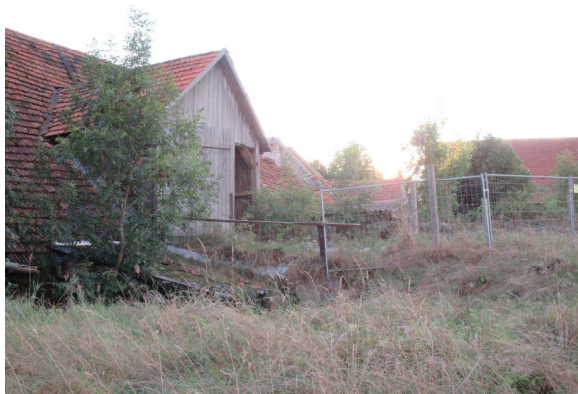
Abb. 6: Rückwärtige Ansicht von Nordosten: Grasweg der zur Erschließungsstraße mit Stellplätzen ausgebaut wird
