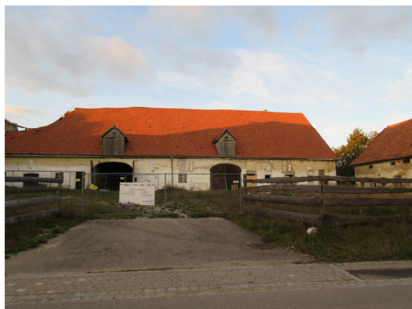
Abb. 8: Blick in den Hof, hier waren ursprünglich alle Stellplätze geplant; im Bebauungsplan ist die Hoffläche nun als Grünfläche festgesetzt und die Stellplätze werden rückwärtig situiert
