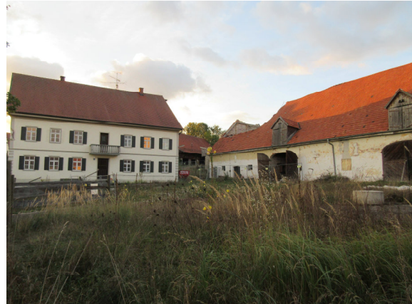
Abb. 5: Innenhof des Dreiseithof mit dem Bauernhaus und der Scheune (nicht im Bild der sog. Wirtschaftshof östlich, rechts)
