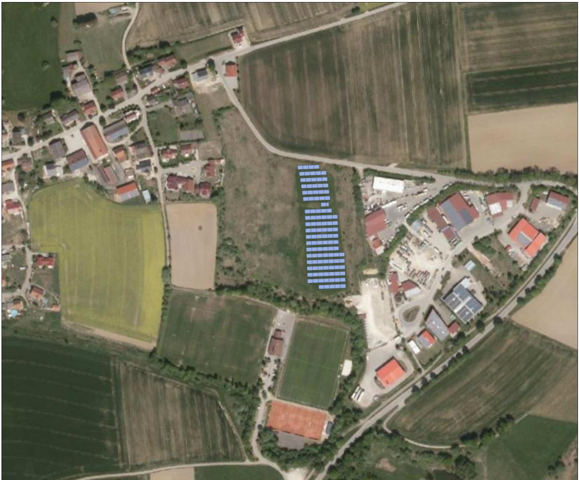
Luftbild 2018 mit zwischenzeitlich errichteten PV-Modulen; maßstabslos, © Bay. Vermessungsverwaltung
